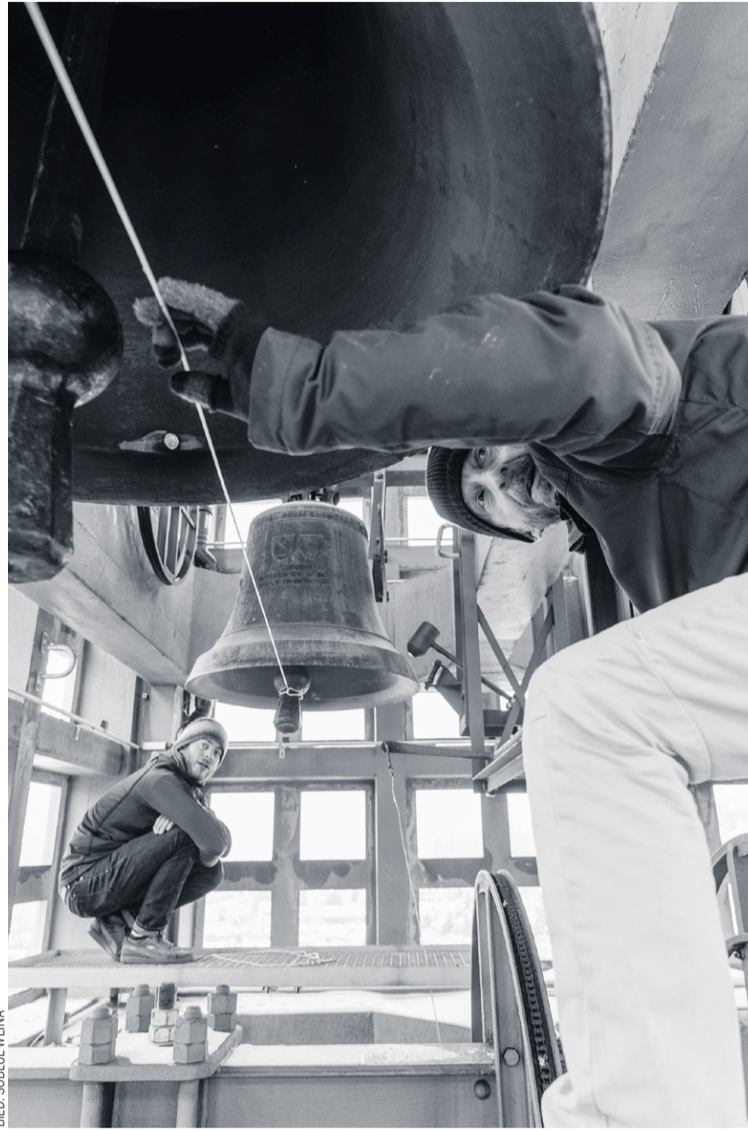
Beat Jaggy (rechts) justiert den Klöppel einer Glocke, damit der Klang genau passt.
