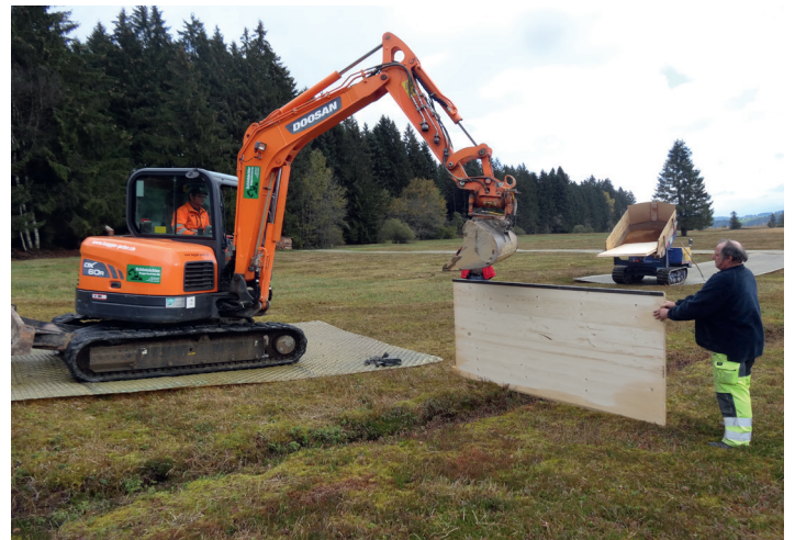
Eine Holztafel quer durch den Graben wird den Wasserabfluss verhindern
